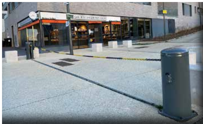
Accès pompier - Noisy le Grand (93)
