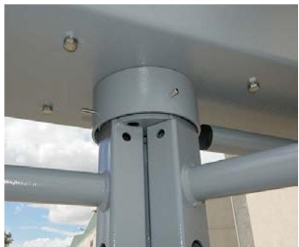
Positionnez les équerres de renfort des peignes du rotor en partie haute et basse, placez les boulons et serrez fortement.
