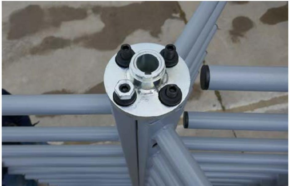
Placez les écrous sur les goujons. Vissez alors alternativement chaque goujon et son écrou jusqu'à obtenir un montage similaire à celui de la photo de droite: écrou à ras du goujon, le silent bloc suffisamment gonflé pour combler l'espace complètement mais sans être trop comprimé de sorte de conserver une certaine souplesse et amortir les vibrations.
