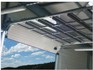
Vue d'ensemble de l'intérieur de la porte
